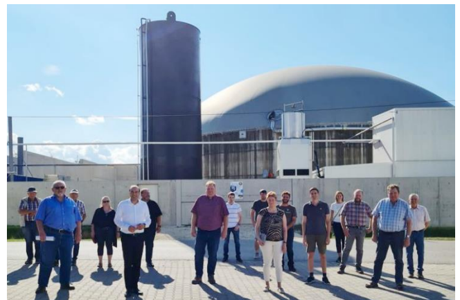
Beeindruckt waren die Besucher der Biogasanlage von Martin Forstner, die zu den größten Biogasanlagen im Landkreis Kelheim zählt. Bundestagsabgeordneter Florian Oßner zollte Anerkennung und Lob für solch technisch hochwertige Investitionen.
