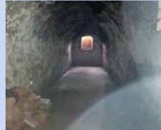
Blick in einem gut erhaltenen Keller
