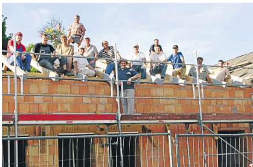
Beim Anbau an die Fahrzeughalle der FFW Alberndorf konnte jetzt das Richtfest gefeiert werden.
