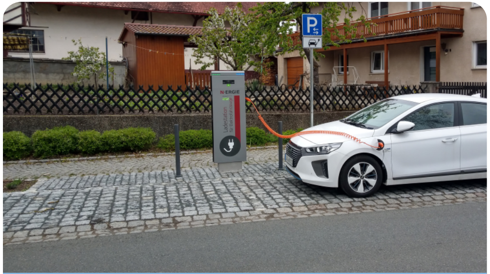
Ladestation für Elektrofahrzeuge in der Oberen Dorfstraße
