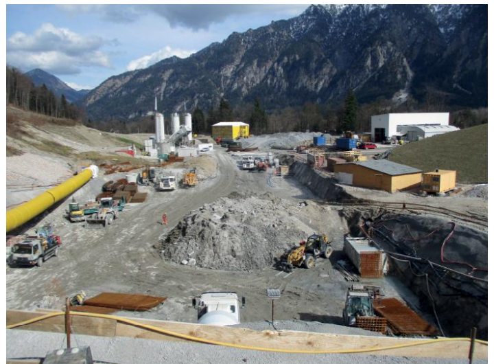
Baustelleneinrichtungsfläche am Südportal
