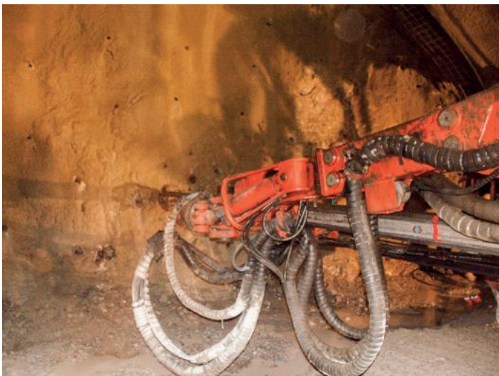
Bohrwagen beim Bohren der Sprenglöcher
