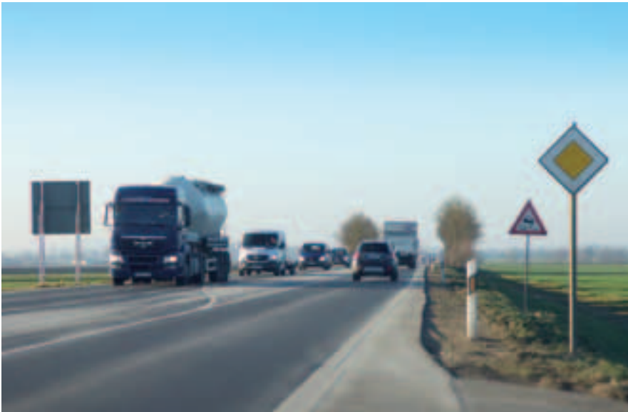
Nördlingen-Möttingen: Der dreistreifige Ausbau wird die Verkehrssicherheit erhöhen.
