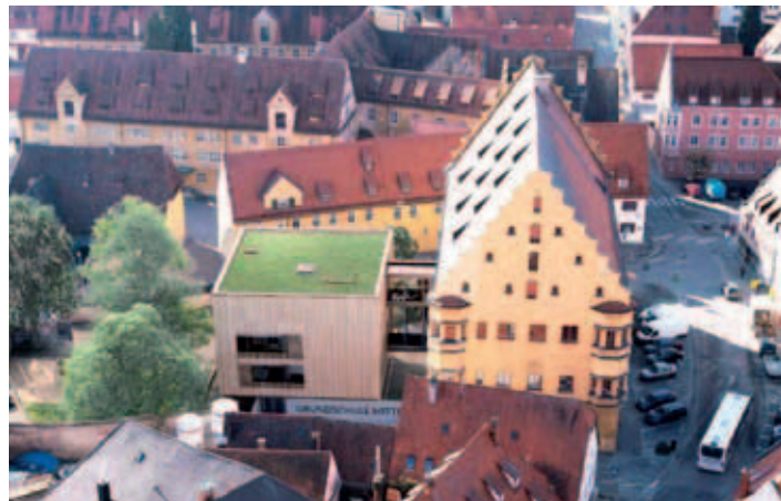
Wohl vom Tisch: Kontrovers wurde in Nördlingen in den letzten Monaten die begrünte Flachdach-Variante des Anbaus an die Grundschule Mitte diskutiert. Nun hat sich auch der Landesdenkmalrat dagegen ausgesprochen
