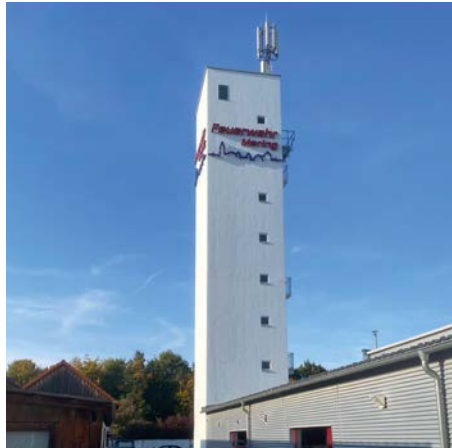
Schlauchturm der Freiwilligen Feuerwehr
