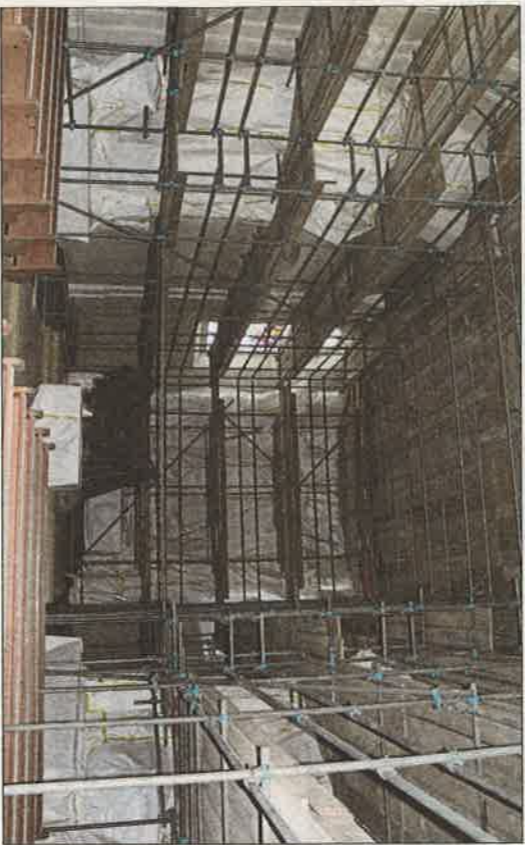
Das Kircheninnere ist derzeit komplett eingerüstet.
