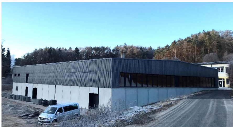
Die neue Turnhalle kostet ca. 1,6 Mio. € mehr als geplant.
