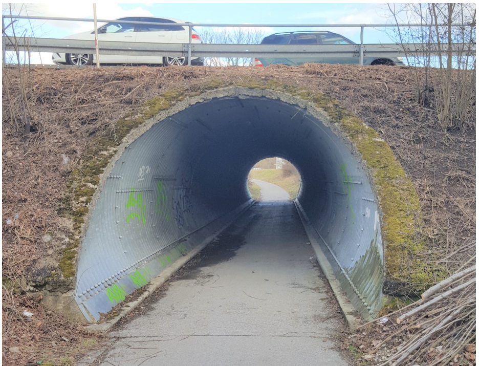
Die Unterführung unter der Kreisstraße M1 östlich Feldkirchen im Zuge des (Fuß- und) Radweges Feldkirchen - Weißenfeld Foto: E. Basler
