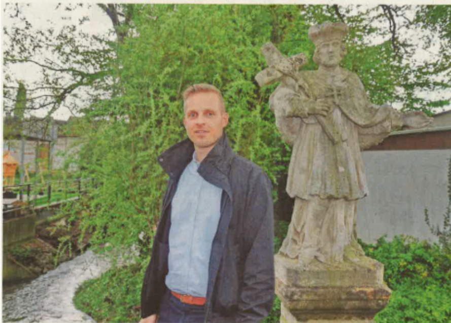
Bezold auf der Nepomuckbrücke, deren Sanierung ins Stocken geraten ist: „Es ist manchmal langwierig und nervenaufreibend, wenn ein Projekt durch Auflagen verzögert wird.“
