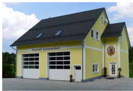
Für die CSU Bärnau war es von Anfang an und auch erweitert (Kosten!) immer selbstverständlich für Schwarzenbach nicht nur ein Feuerwehrhaus, sondern ein Haus der Gemeinschaft zu schaffen.
