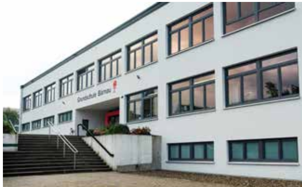
Nahezu komplette Generalsanierung der gesamten Grundschule inkl. großer Schulturnhalle.
