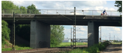
Die Bahnbrücke an der Südumgehung
