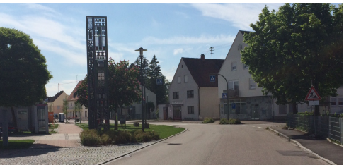
Nächster Sanierungsabschnitt in der Hauptstraße
